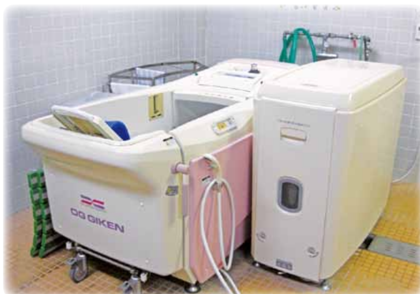
車いすに乗ったまま入浴が出来る特殊浴槽です。
